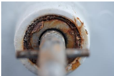
PE ライン除去後のシールフランジ
